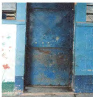
Foto 3: 4.2 Reposición de chapa, para puerta de metal.
