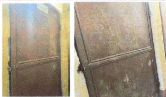
Foto 9: 4.1 Mantenimiento a estructura (lijado, cambio de tubo, cepillado, sujeciones, aplicación de pintura)
