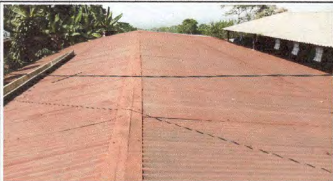
Foto1: 1.1 Sustitución de lamina.
