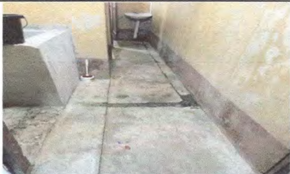
Foto 7: 6.8 Sustrucción piso cerámico baños.
