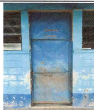
Foto 4: 4.2 Reposición de chapa, para puerta de metal.
