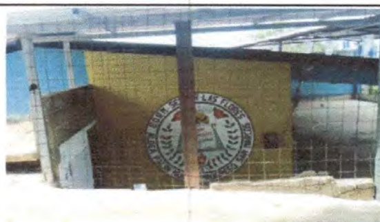
Foto 12: 15.2 Reparación de muro perimetral de block con tubo hg y malla galvanizada, soleras intermedias y columnas.
