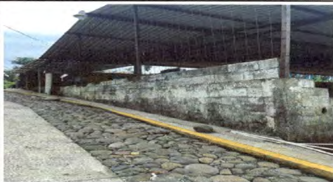
Foto 14: 21.1 Repello de muro.
