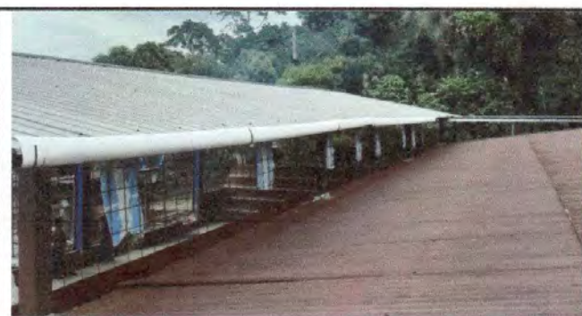
Foto 5: 7.2 Reposición de canales de PVC.
