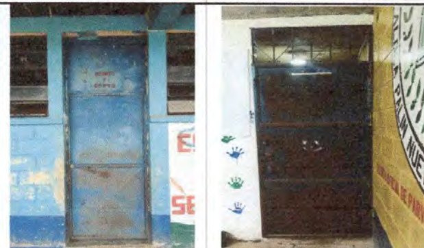
Foto 2: 4.1 Reparación de 7 puertas de metal y pintura
